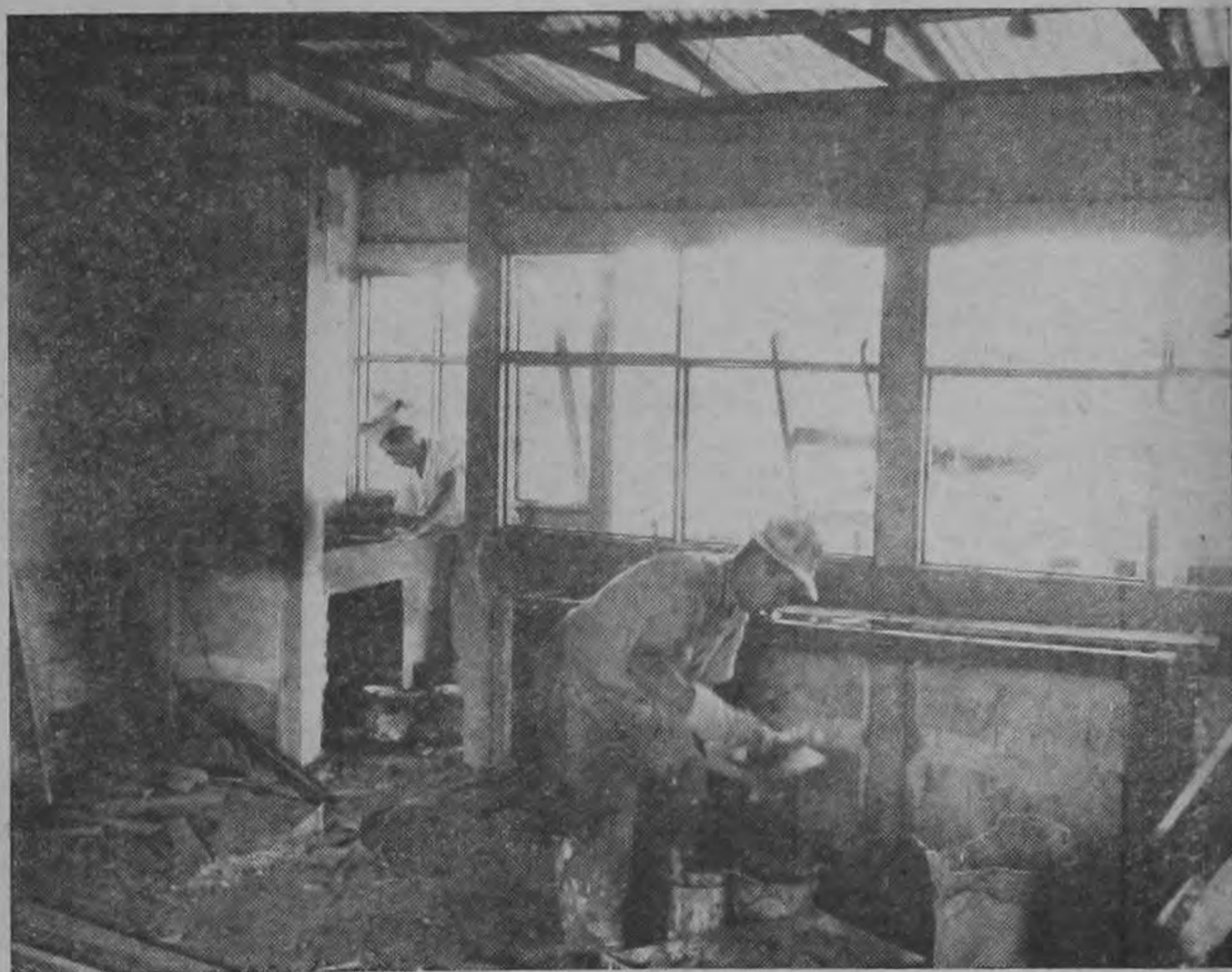
Vista interior de una de las 122 casas que el INVU está construyendo actualmente en la Unidad Vecinal de Hatillo y que adjudicará este año. Los trabajadores dan los últimos toques a las pilas y estantes de cocina.
